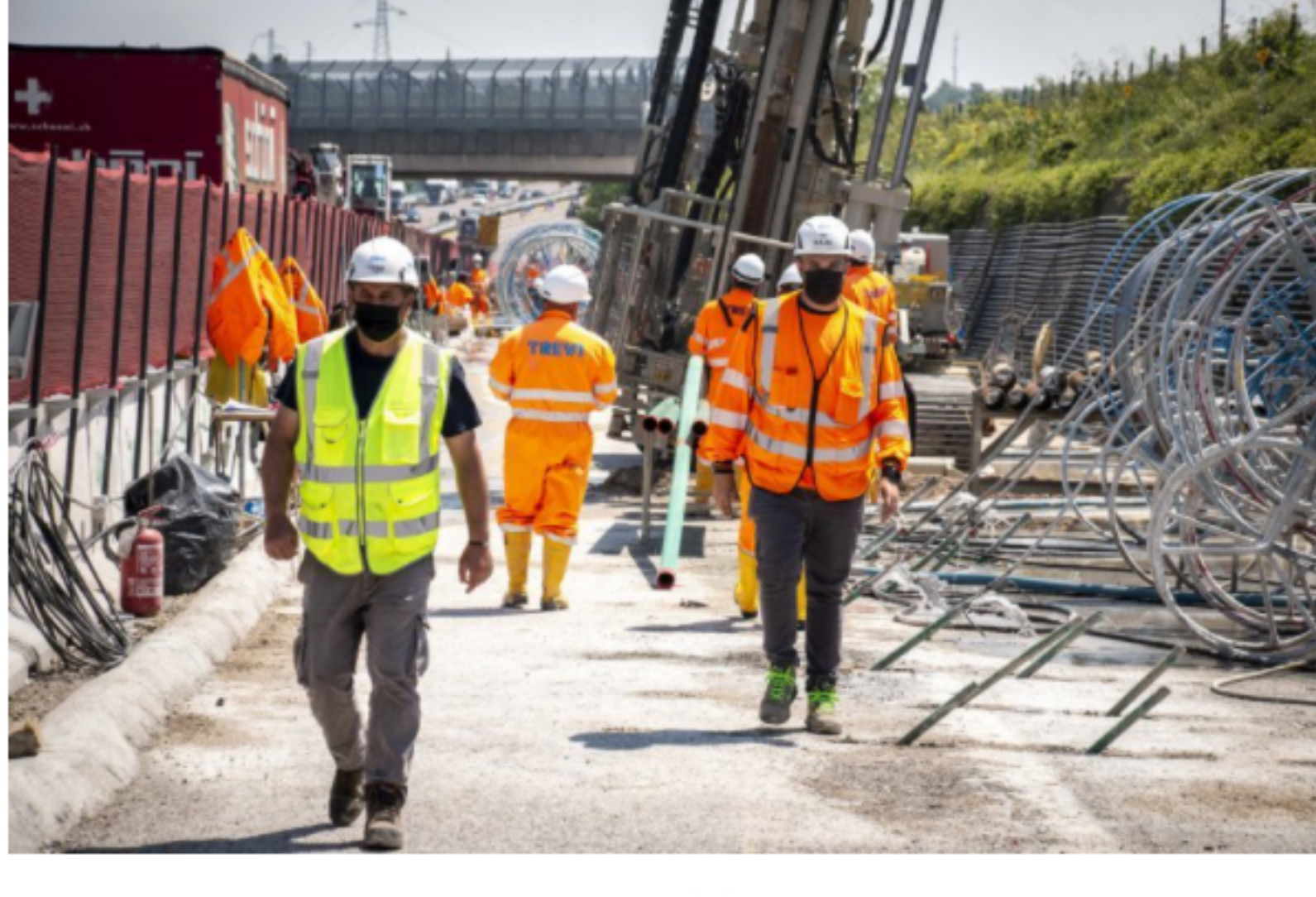
TREVI Tunnel of Lonato Image source: TREVI - Finanziaria Industriale S.p.A.
