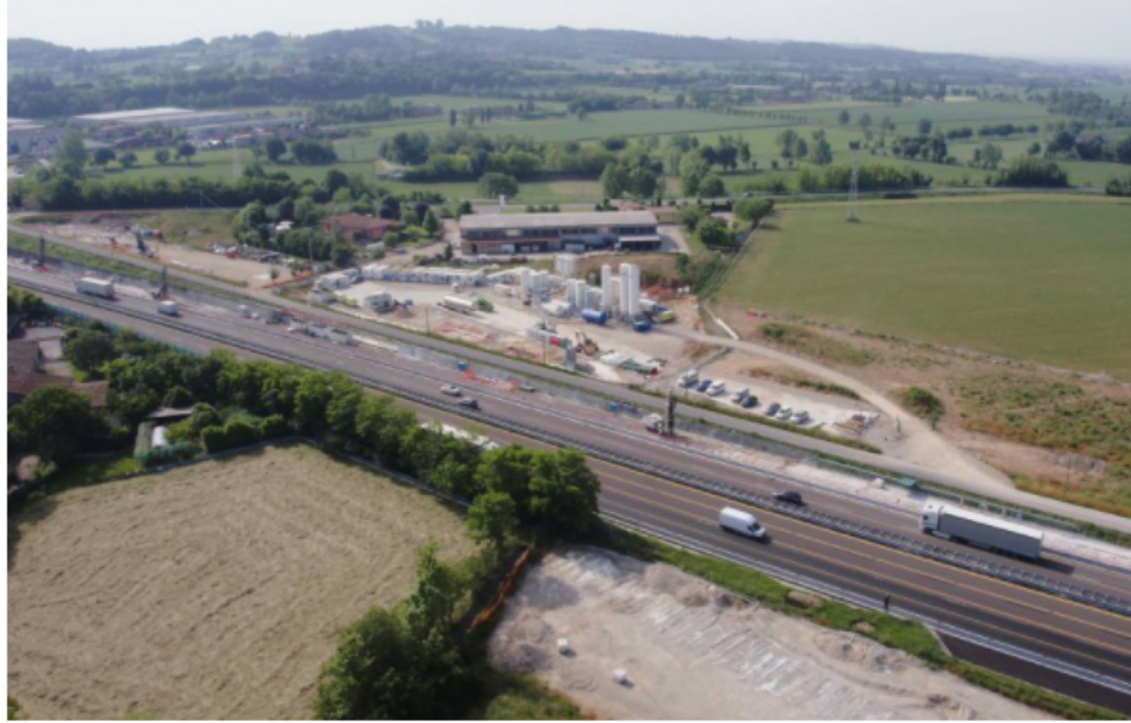
TREVI Tunnel of Lonato Image source: TREVI - Finanziaria Industriale S.p.A.
