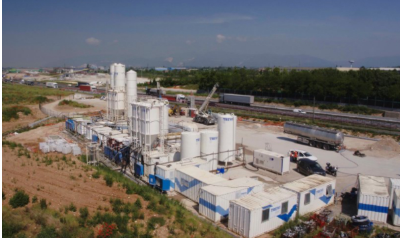
TREVI Tunnel of Lonato Image source: TREVI - Finanziaria Industriale S.p.A.
